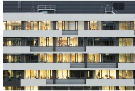
Bild: ©Gerber Architekten_H-J_Landes_IC_8 Die neuen Balkone werden teils mit einer geschlossenen Aluminiumverkleidung, teils ausgebildet
