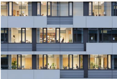
Bild: ©Gerber Architekten_H-J_Landes_IC_9 Durch die Dreibundstruktur erhalten alle Büros des IC-Gebäudes eine natürliche Beleuchtung und Belüftung
