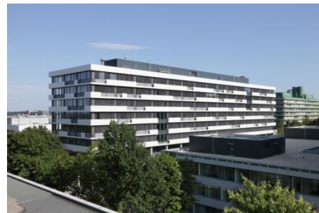
Bild: ©Gerber Architekten_H-J_Landes_IC_6 Die horizontale Bandstruktur der Fassade des IC-Gebäudes wurde beibehalten
