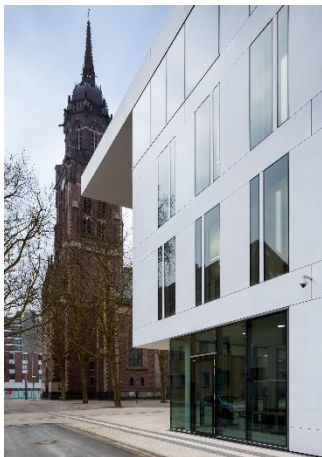
Bild: Volksbank Krefeld_027 Die neue Volksbank in Krefeld befindet sich in unmittelbarer Nähe zur Dionysiuskirche.
