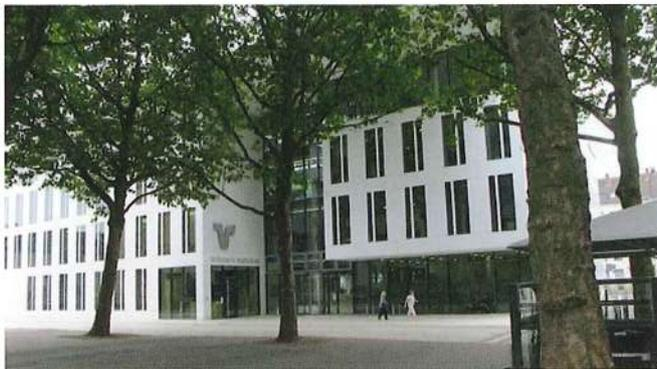
**Bild 1** Die Hauptstelle der Volksbank Krefeld wurde mit einer eleganten, flächenbündigen Fassade aus Fertigteilen mit Dyckerhoff WEISS errichtet.
