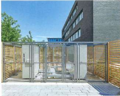
Zwei gasmotorische Wärmepumpen erzeugen die erforderliche Wärme und Kälte
