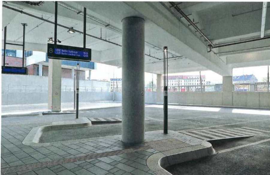
Pfeiler in der Rampe: An dieser Stelle kollidieren Parkhaus-Raster und die daruntergesetzte Bussteignutzung
