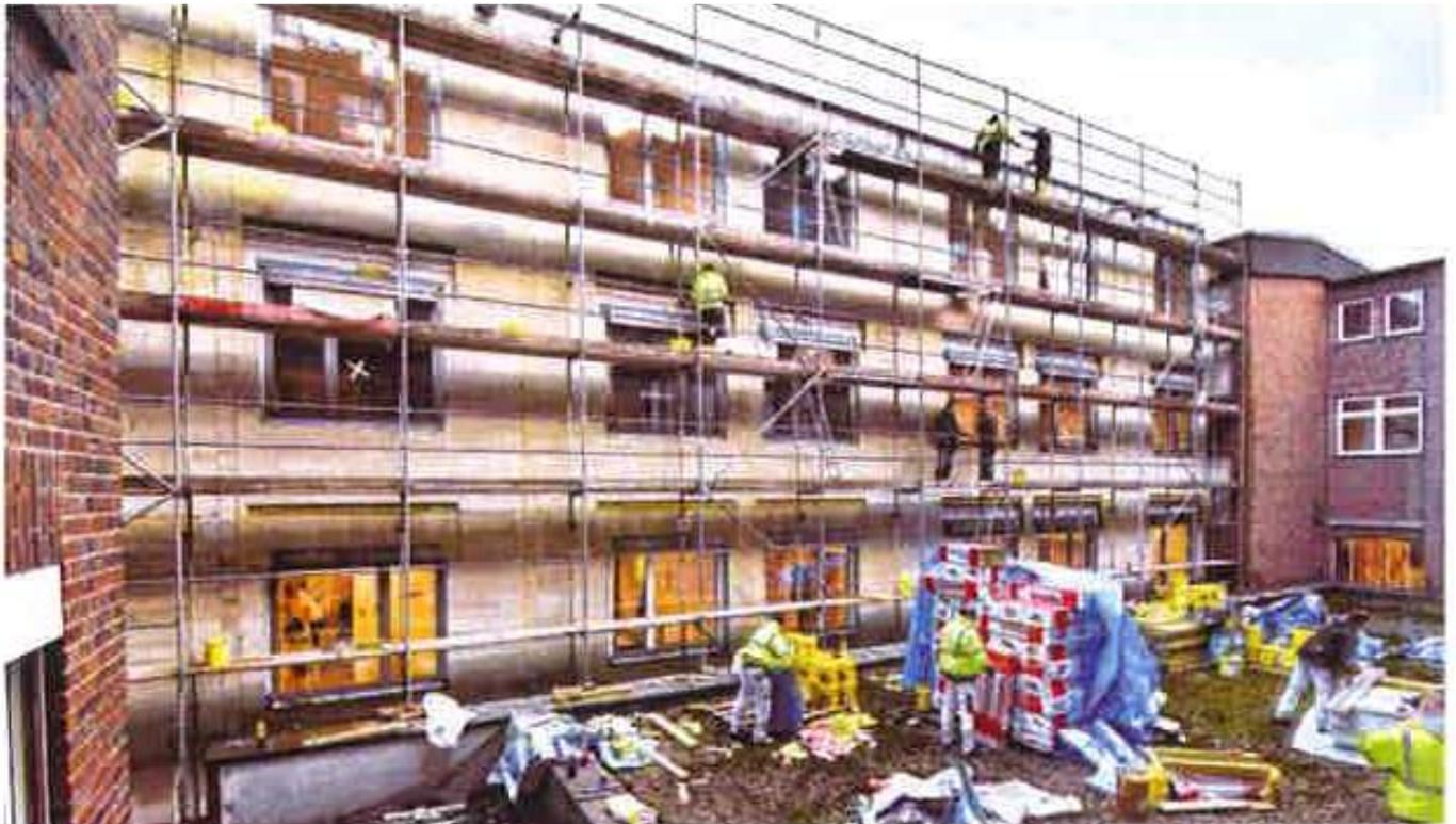
Der Querriegel im Innenhof des St.-Barbara-Hospitals steht, außen wird gerade die Wärmedämmung an die Fassade angebracht.
