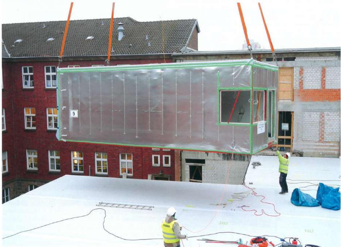
*Bild 1. Ein vorgefertigtes Modul wird per Kran über die Bestandsbauten des St. Barbara Hospitals in Gladbeck hinweggehoben in den allseits umschlossenen östlichen Innenhof und dort vor Ort mit den weiteren Einzelmodulen präzise zusammengefügt*
