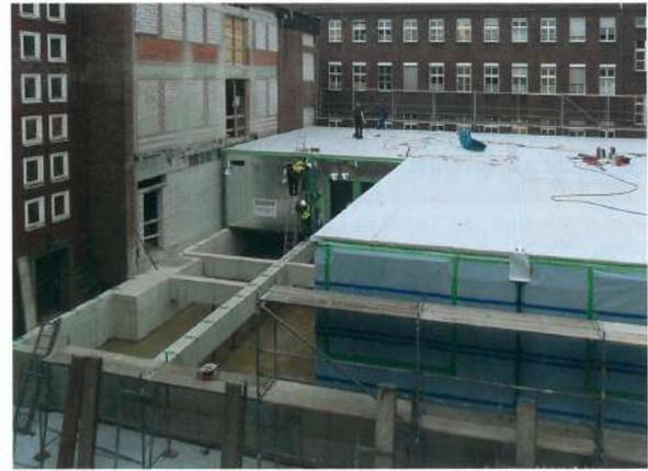
**Bild 6.** Millimeter für Millimeter wurde jedes Modul präzise aufgesetzt und zusammengefügt, jeder zusätzliche Millimeter summiert sich bis zum letzten Modul, das eingebracht wird – der Aufbau aller Module war Maßarbeit
