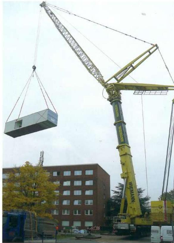
**Bild 4.** Das erste Modul wiegt 28 t, in ihm ist die Aufzugsbasis für den Fahrstuhl, der die Neubaugeschosse bis ins zweite Obergeschoss verbindet, untergebracht
