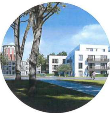
Auf dem früheren Krankenhausgelände in Ochsenzoll sind 1000 Wohnungen entstanden. SIMULATION: GERBER ARCHITEKTEN
