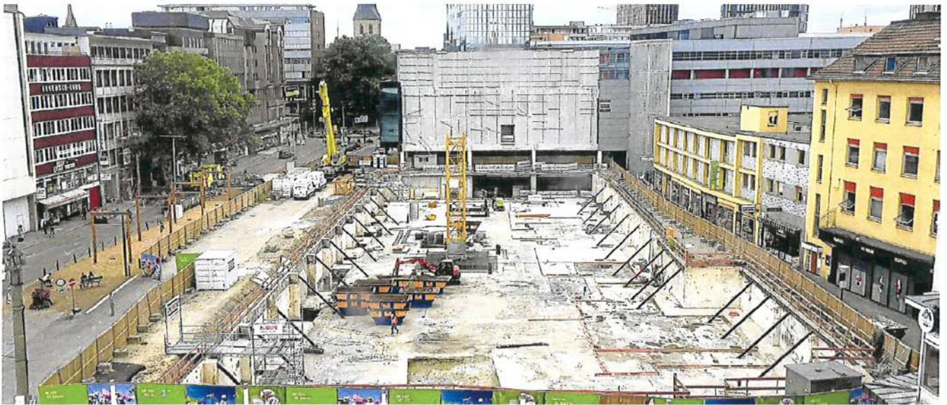
In der Baugrube für das Basecamp gibt es erste Zeichen für den Baustart. Ein Kran wird aufgebaut und Betonfundamente werden gegossen.
