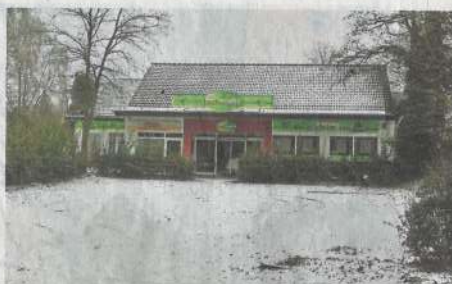
Seit Jahren ist der Frischmarkt Schober an der Holbeinstraße geschlossen. Jetzt gibt es Baupläne für das Gelände. —FOTO: RALF DEINL
