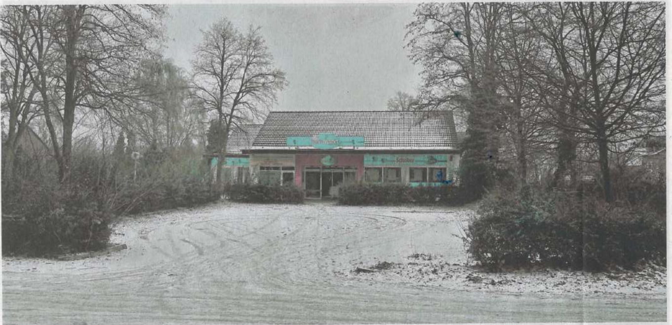
Seit Jahren ist der Frischmarkt Schober an der Holbeinstraße geschlossen. Jetzt gibt es Baupläne für das Gelände.
