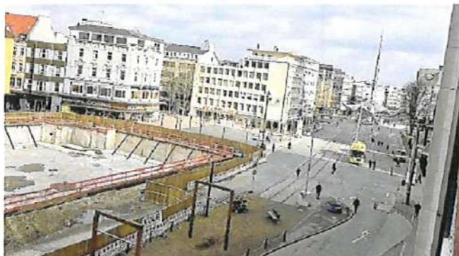
Die Baugrube ist inzwischen besenrein und wartet auf die ersten Bauarbeiter, die das neue Gebäude im Herzen der Stadt hochziehen.
