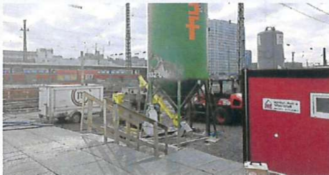
Der Umbau des Hauptbahnhofs
