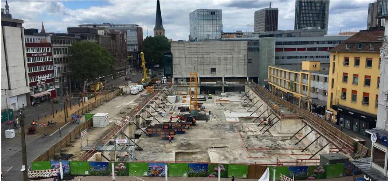
In der Baugrube für das Basecamp gibt es erste sichtbare Zeichen für den Baustart. Ein Kran wird aufgebaut und Betonfundamente werden gegossen.
